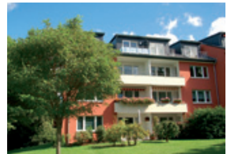
WOHNQUARTIER Wohneinheiten: 16 Stadtteil: HH-Wilstorf Bauträger: Bruhns Gruppe
